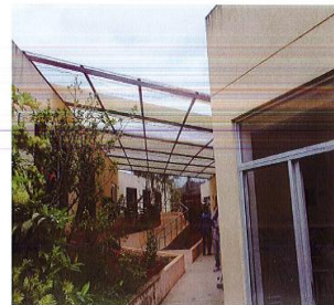
PERSIANA EN POLICARBONATO POR CAMBIAR( 130 M2 ) Y AMPLIAR (168 M2)
