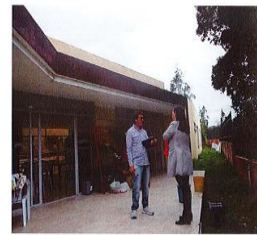
SITIO DE BODEGA POR CONSTRUIR AREA 22 M2
